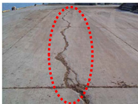
写真 2-01 : 劣化度判定 『a』
