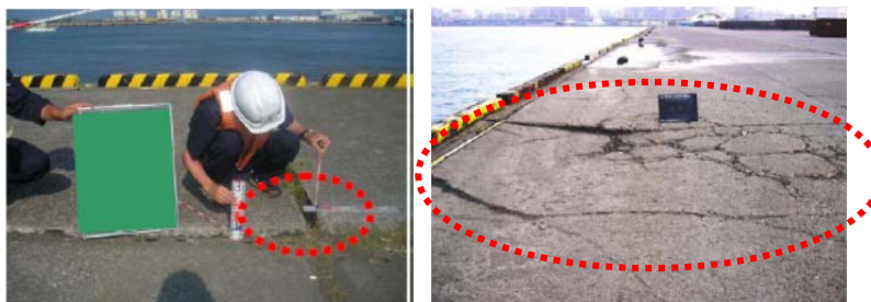
写真 3-2.2 エプロンの変状の事例
