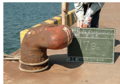
写真 3-7.1 係船柱の変状の事例
