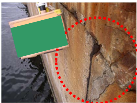
写真 4-03：劣化度判定『b』
