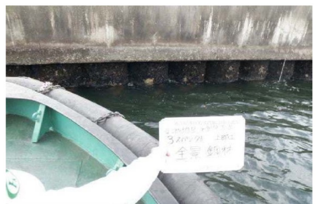
（海上目視調査の点検状況）
