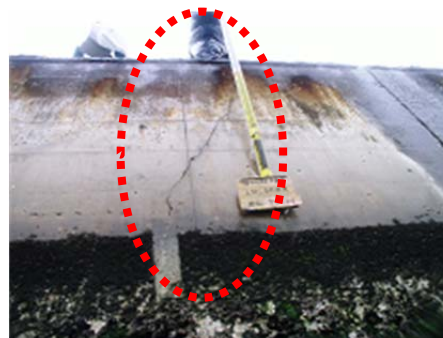
写真 4-04：劣化度判定『b』
