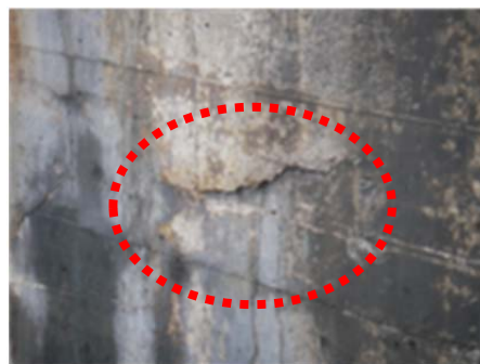
写真 4-02：劣化度判定『b』
