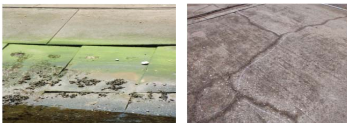
写真 3-6.5 斜路部の変状事例
