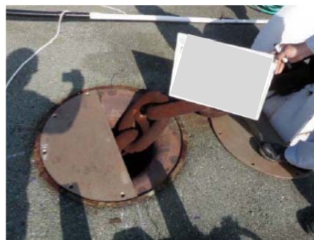
写真 3-5.2 チェーンホール
