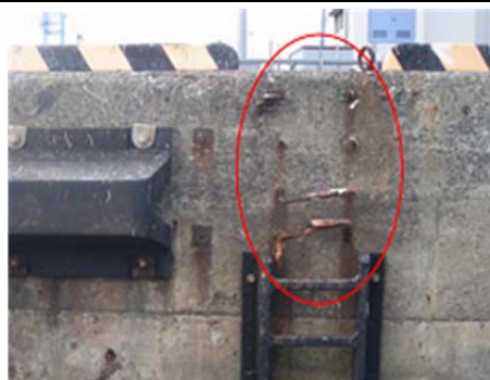
写真 6-04：劣化度判定『a』
