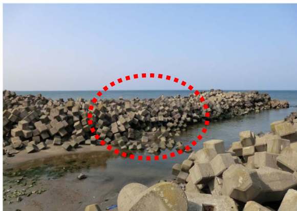
写真 2-3.2 捨石式傾斜堤の変状例
