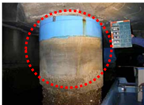
写真 3-01 : 劣化度判定 『 a 』
