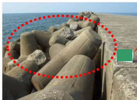
写真 4-02：劣化度判定『b』
