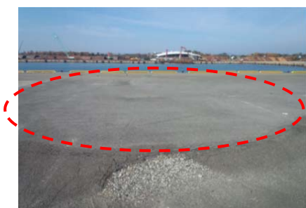
写真 3-6.1 エプロンの沈下事例
