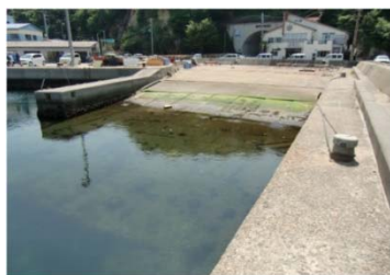
写真 3-6.4 船揚場の全景
