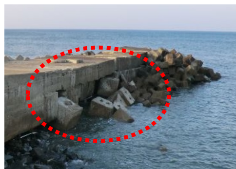
(コンクリートブロックの抜き出し)
