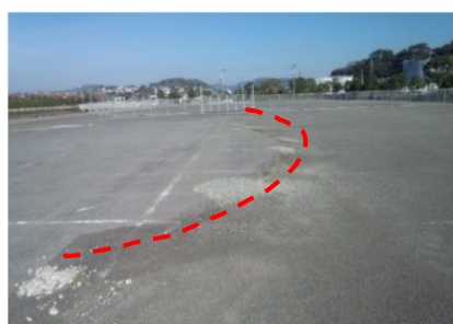
写真 3-6.2 エプロンの沈下、陥没
