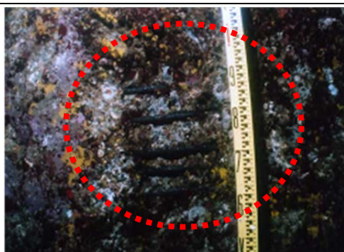
写真 3-02 : 劣化度判定 『 a 』
