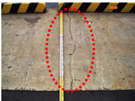
写真 4-01：劣化度判定『b』
