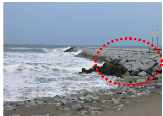
写真 2-3.2 捨石式傾斜堤の変状例
