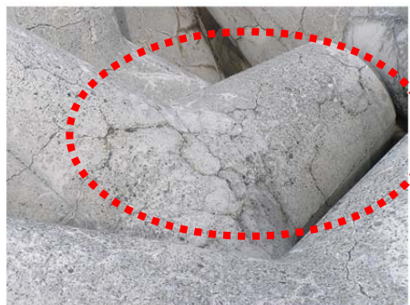
写真 4-03：劣化度判定『c』
