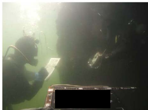
写真 3-3. 3 潜水目視状況
