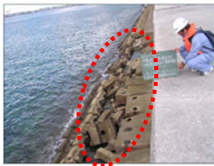
写真 5-01：劣化度判定『a』
