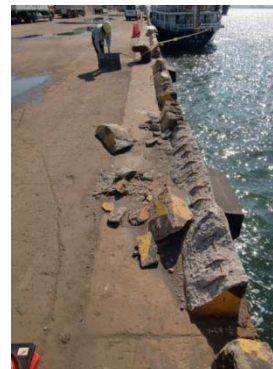
写真 3-7.3 車止めの変状の事例
