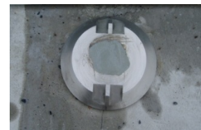
写真 3-3.1 電位測定端子
