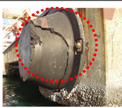
写真 5-04 : 劣化度判定 『a』
