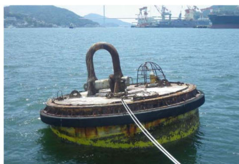
写真 3-6.3 係船浮標の外観
