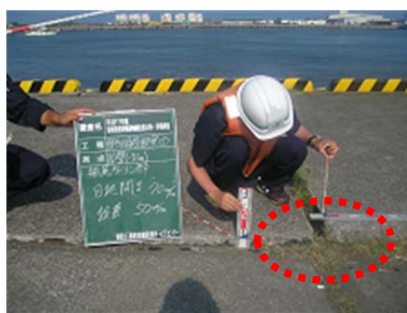
写真 2-02 : 劣化度判定 『a』
