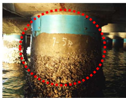
写真 3-02 : 劣化度判定 『 a 』
