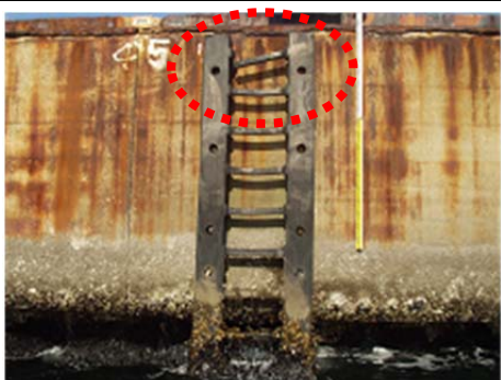
写真 6-01：劣化度判定『a』
