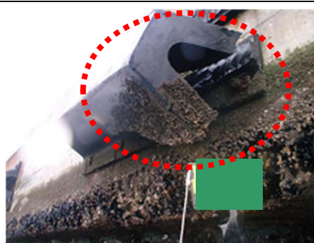
写真 5-02 : 劣化度判定 『a』
