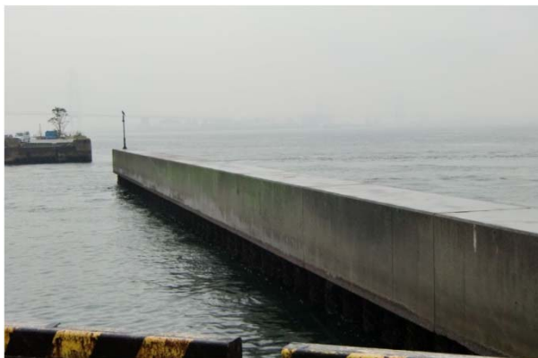
（陸上目視の点検状況）
