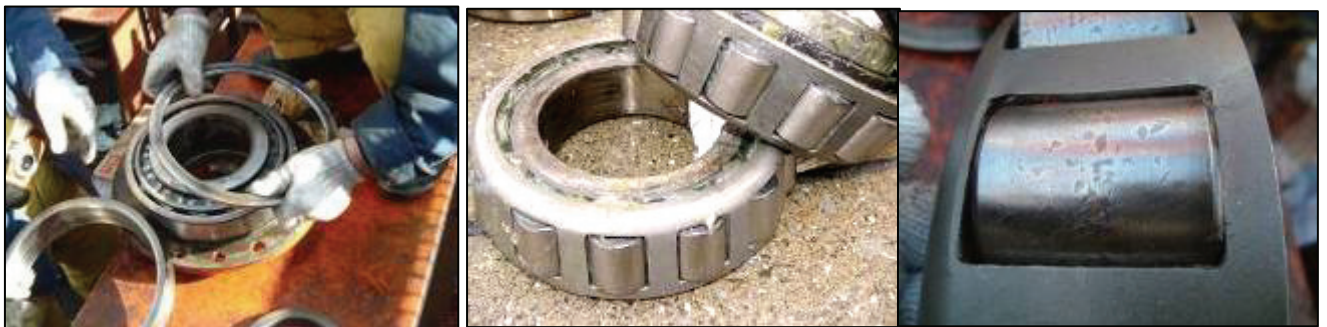
図II-9.1 トロリ車輪軸受の状況
