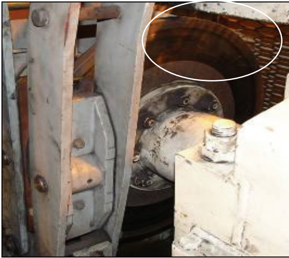
図 II-4.1 ブレーキディスクの摩耗、劣化度[a]
