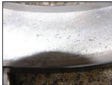
図II-9.2 トロリ車輪軸受外輪の腐食状況、劣化度[a]
