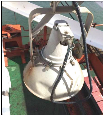
図Ⅱ-16.1 照明装置の状況、劣化度[c]
