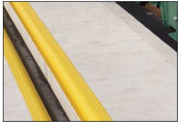
図Ⅱ-1.2 ケーブル溝の状態、劣化度[d]
