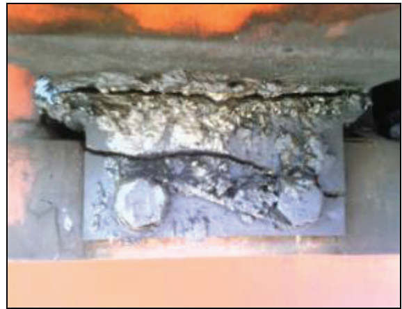
図Ⅱ-15 スライドプレートの破損、劣化度[a]
