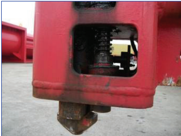
図Ⅱ-14 ツイストロックピンの状況、劣化状況[c]
