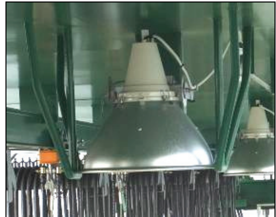
図Ⅱ-16.2 照明装置の状況、劣化度[d]
