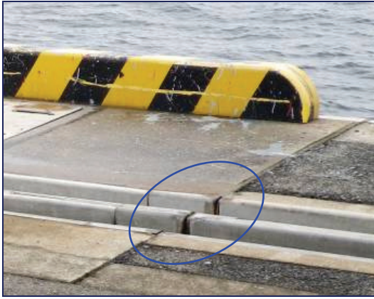
図Ⅱ-1.1 ケーブル溝の状態、劣化度[b]
