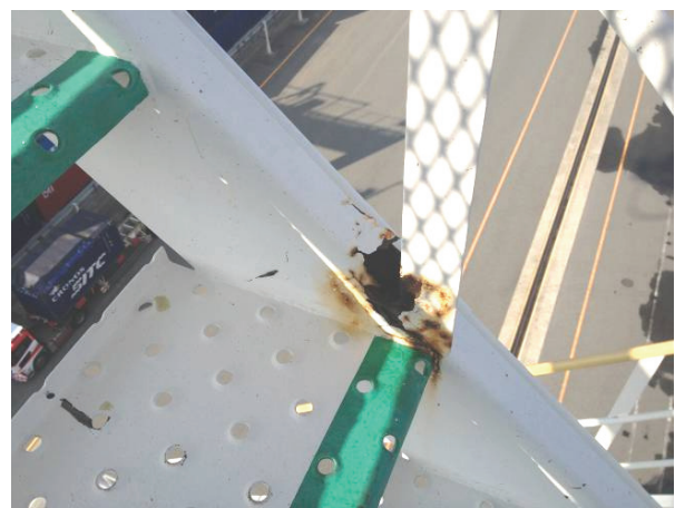
図Ⅱ-3 階段手摺り基部の腐食、劣化度[b]
