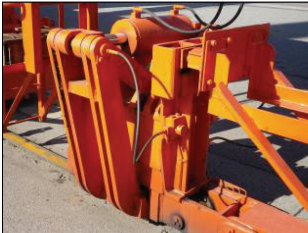
図Ⅱ-12.2 レールクランプの状況（レバー式）、劣化度[d]
