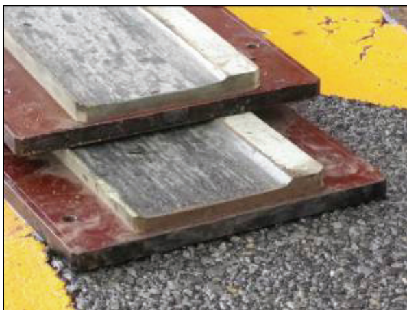
図Ⅱ-13.1 レールブレーキ・パッドの状況、劣化度[a]
