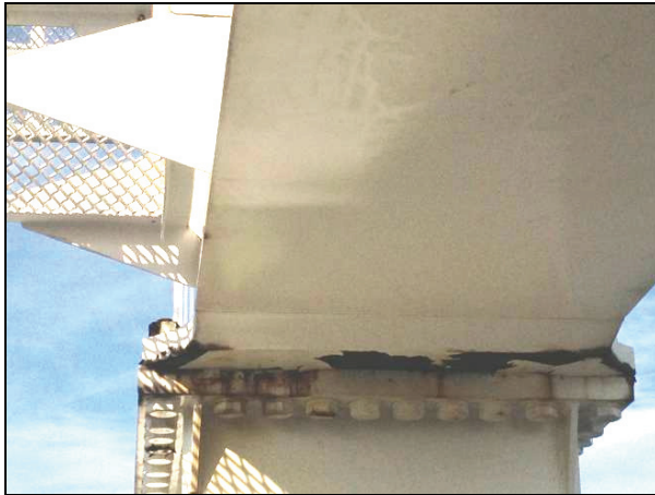
図Ⅱ-2.1 タイブーム下部の塗装状況、劣化度[a]
