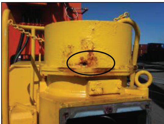
図Ⅱ-11.3 走行ブレーキ蓋の腐食、劣化度[a]
