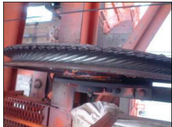
図 II-7 主巻シーブの条痕、劣化度[a]
