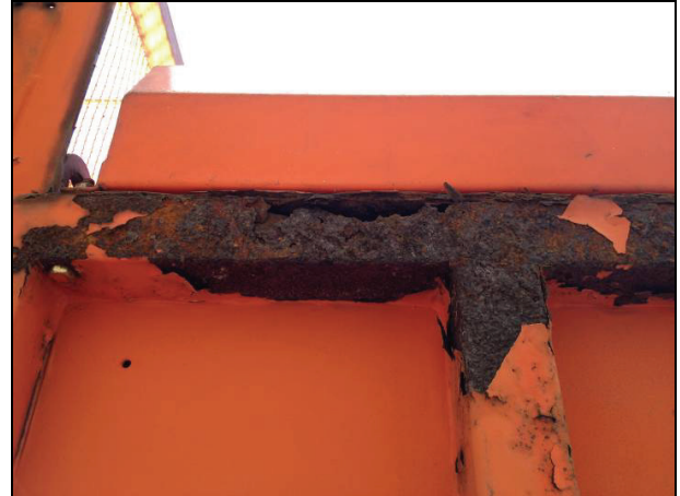
図Ⅱ-2.2 鋼構造部の塗装状況、劣化度[a]
