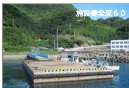
一部に損傷・劣化有り
