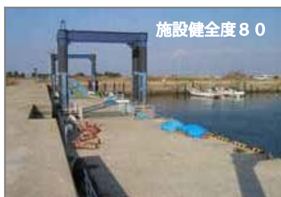
特に損傷なし
