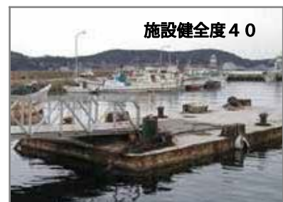
全体的に損傷、腐食有り
