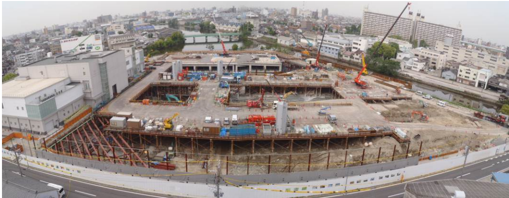
高度処理の導入を進める露橋水処理センター
