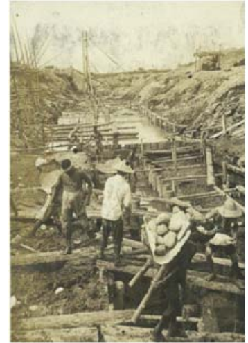
運河の開削状況
