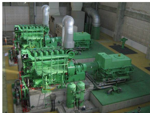
運河の治水機能を発揮する中川口ポンプ所のディーゼルポンプ(口径2,200mm)
