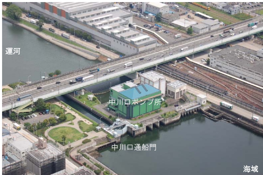
中川口ポンプ所:運河内水を海域に排水する機能 中川口通船門 :市街地への海水の浸入を防ぐ機能
