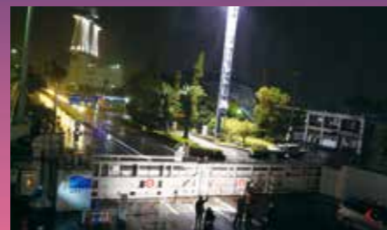
電動式防潮扉 ガーデンふ頭の防潮扉を電動化。少ない人手で迅速な稼働が可能になり、災害を未然に防ぐ上で効果を発揮します。
