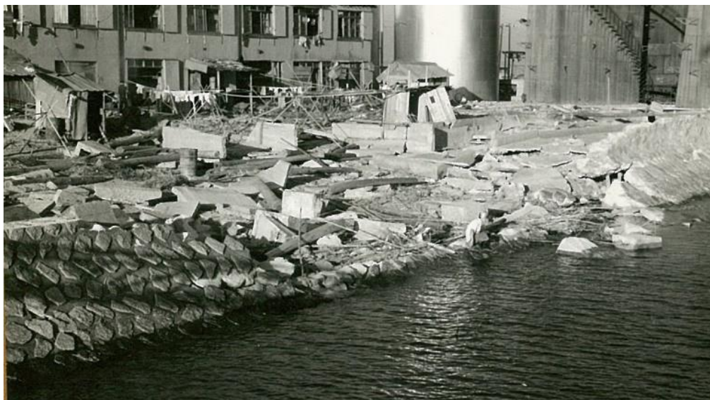
破損した護岸（現在の船見ふ頭）
