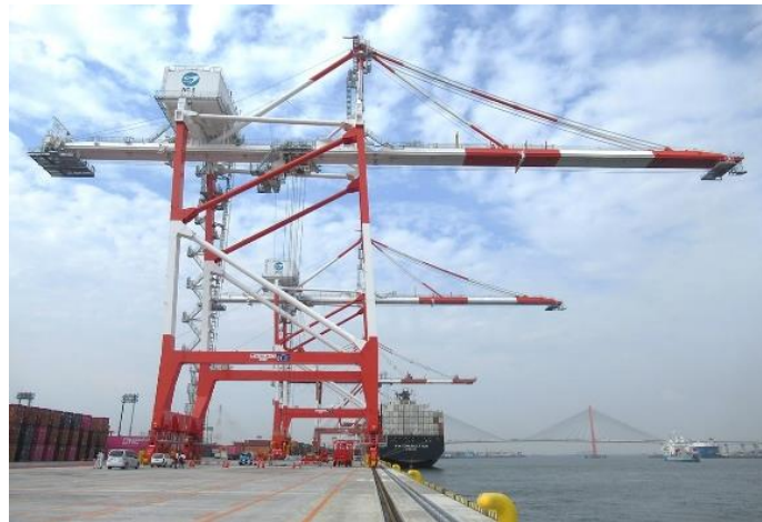
飛島ふ頭 R1 岸壁の供用
