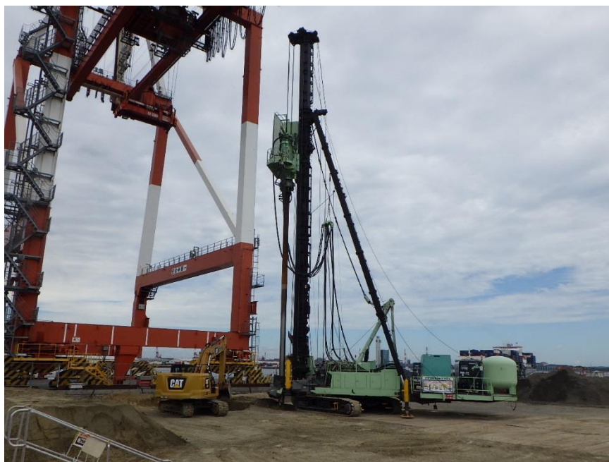
岸壁工事（護岸部の改良） 中部地方整備局提供
