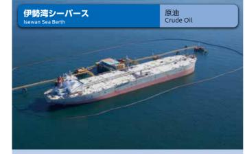
南北500m、水深26mの固定桟橋式の洋上原油受け入れ基地です。十 分な水深を求めて高潮防波堤から南約10kmの沖合に1975年(昭和50 年)完成。31万重量トン級タンカーの係留が可能です。原油は、2本のパイ プラインを通して約9km離れた北浜・南浜ふ頭の石油基地へ送られます。
