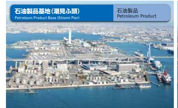
約210万m<sup>2</sup>のスケールの人工島。1961年(昭和36年)に完成しました。 立ち並ぶ石油タンクの総貯蔵能力は約80万kl。名古屋市など周辺地域への エネルギー供給基地として活躍。数々の危険物施設を高潮から守るため、基 地は名古屋港基準面より+6.0m~6.5m高の防潮壁に囲まれています。
