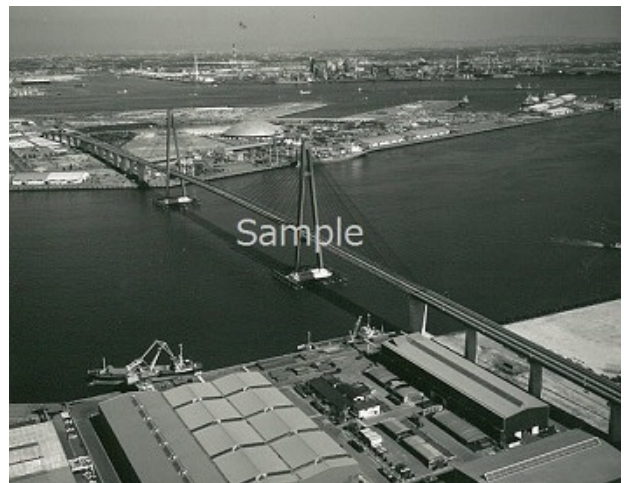
1985(昭和 60)年：名港西大橋開通
