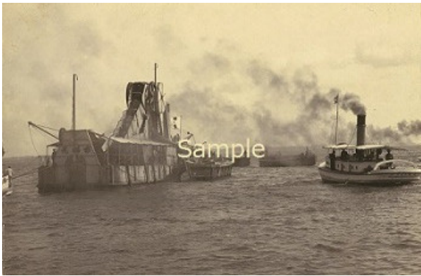
1900(明治 33)年：オランダより輸入されたじょれん式浚渫船「市松丸」
