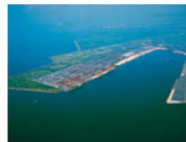
鍋田ふ頭 コンテナターミナル
