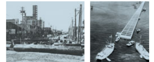
伊勢湾台風の被害と建設中の高潮防波堤。
