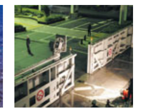
電動化された防潮壁
