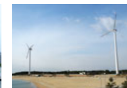
風力発電施設
