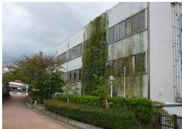
緑化された産業空間 （兵庫県・尼崎運河）
