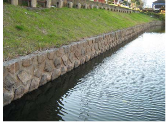
運河建設当初からの石積み護岸
