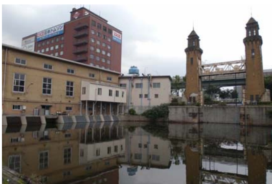
水循環の要となる松重ポンプ所
