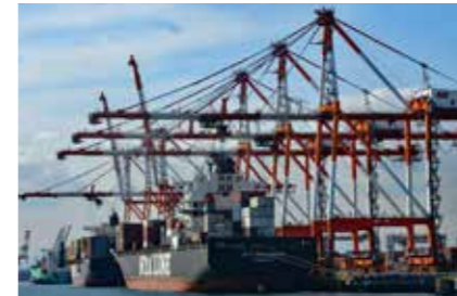
ガントリークレーン
