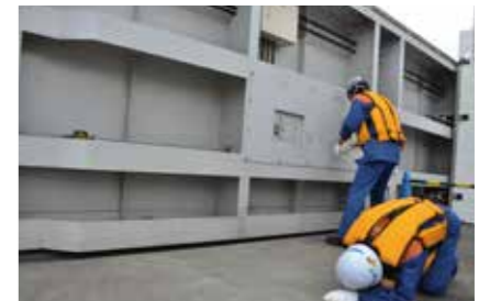
防潮扉の閉鎖訓練
