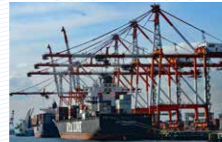
ガントリークレーン
