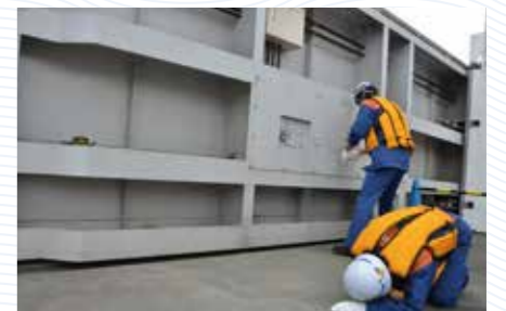
防潮扉の閉鎖訓練
