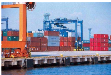
耐震強化岸壁(鍋田ふ頭第2バース(T2))
