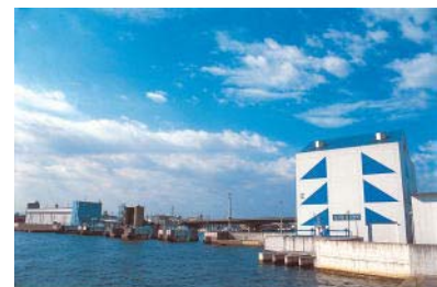
堀川口防潮水門ポンプ所
