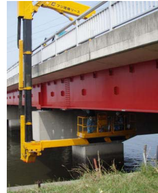
橋梁の管理点検
