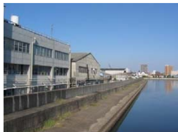
大手ふ頭防潮壁
