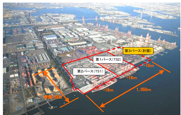
飛島ふ頭南側コンテナターミナル
