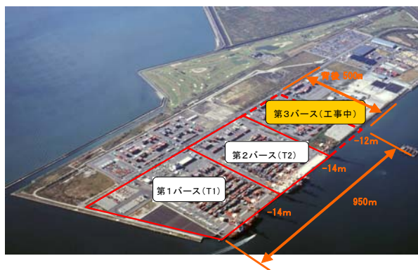
鍋田ふ頭コンテナターミナル
