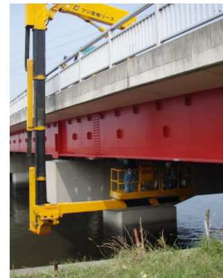
橋梁の管理点検
