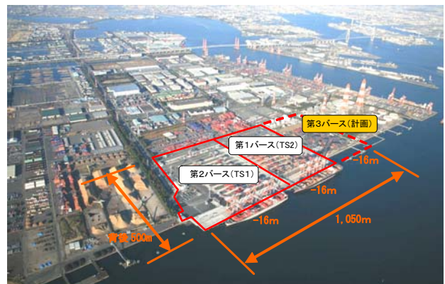
飛島ふ頭南側コンテナターミナル
