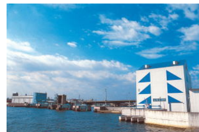
堀川口防潮水門ポンプ所
