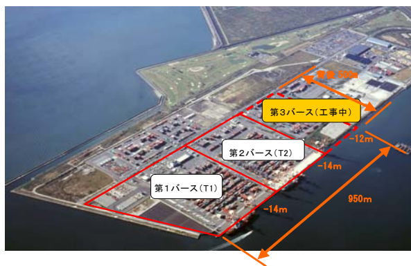
鍋田ふ頭コンテナターミナル
