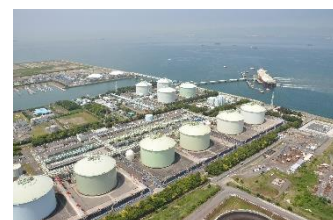
南 5 区の LNG タンク
