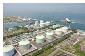
南5区のLNGタンク
