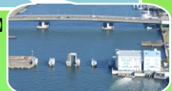
堀川口防潮水門及びポンプ所
