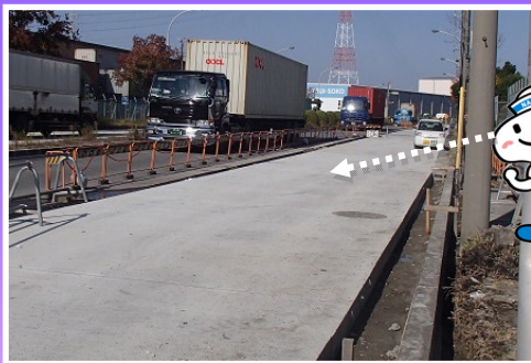
飛島心頭道路（改良）整備事業 整備状況
