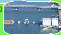
堀川口防潮水門及びポンプ所
