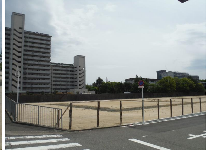
北東（市道金城埠頭線）から見た対象土地
