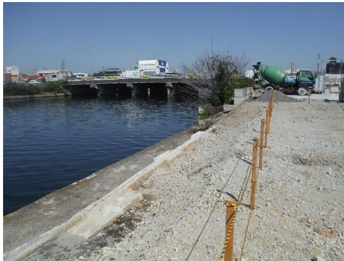
対象地から昭和橋方向
