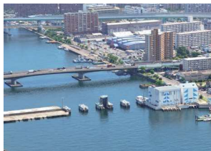
堀川口防潮水門
