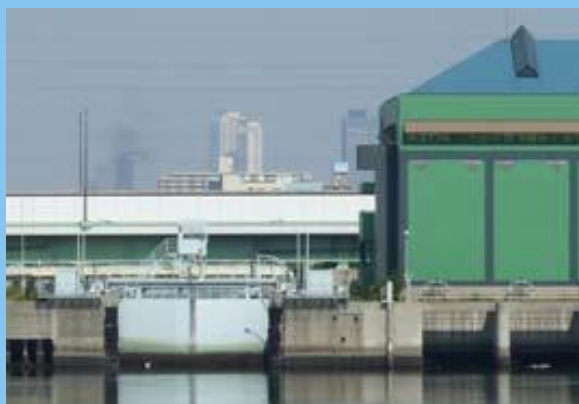
中川口ポンプ所
