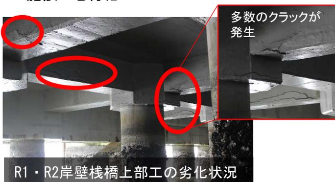
飛島ふ頭東側(NCBコンテナターミナル)の水深12m岸壁(R1、R2)は、供用開始から40年以上が経過し、施設の経年的劣化が著しく、大規模修繕が必要な状況にある。
