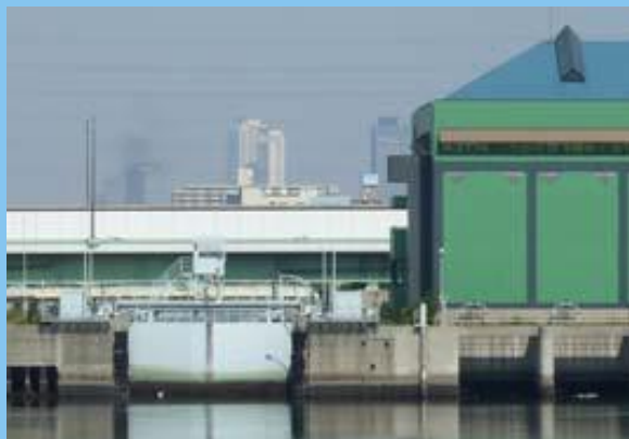
中川口ポンプ所
