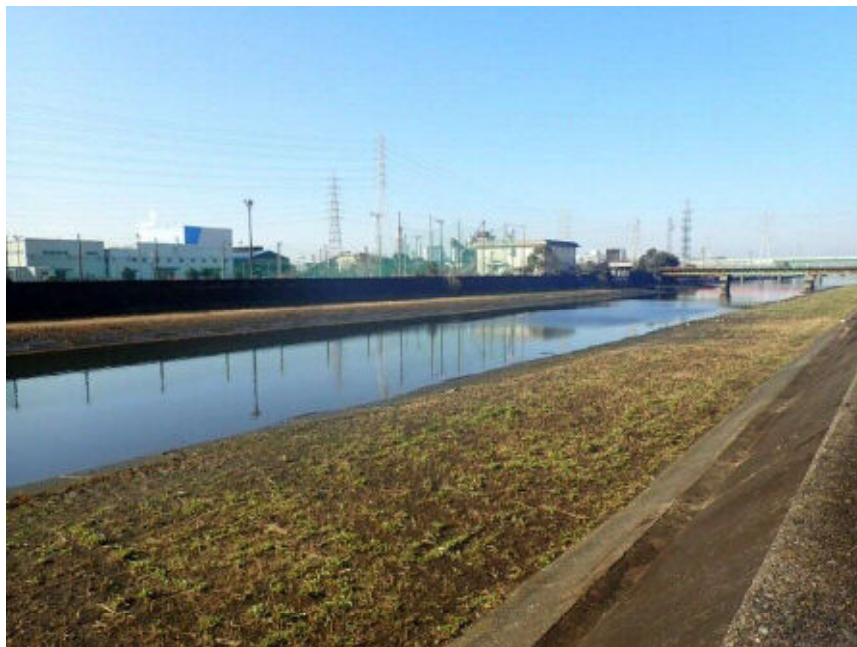
図 1-2-1 現在の大江川の様子（大江ポンプ所下流側から臨海鉄道東港線方向を望む）
