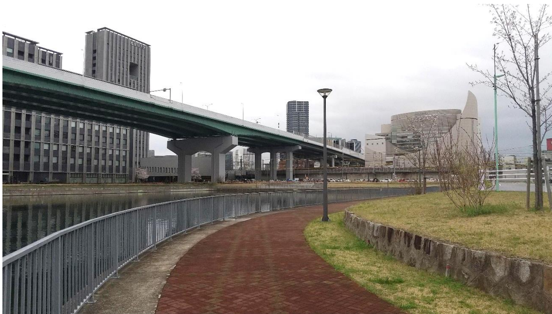
② 南東側園路から東方向
