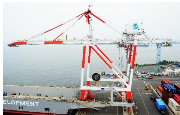
インバータ制御方式のガントリークレーンの導入 (T1岸壁に設置された新3号機)
