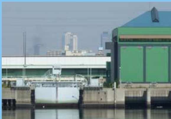
中川口ポンプ所
