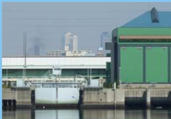
中川口ポンプ所
